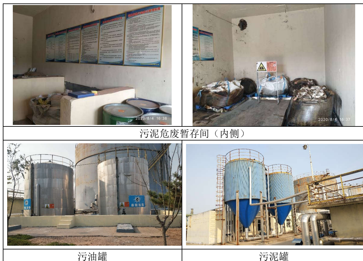
图4.1-4 固废环保设施建设情况
