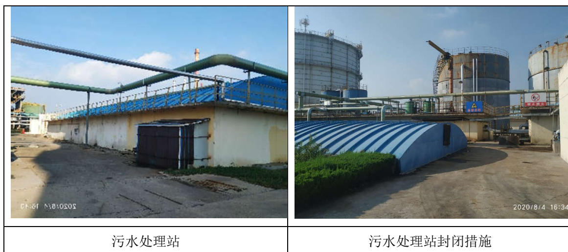
图4.1-2 项目依托废水治理设施
