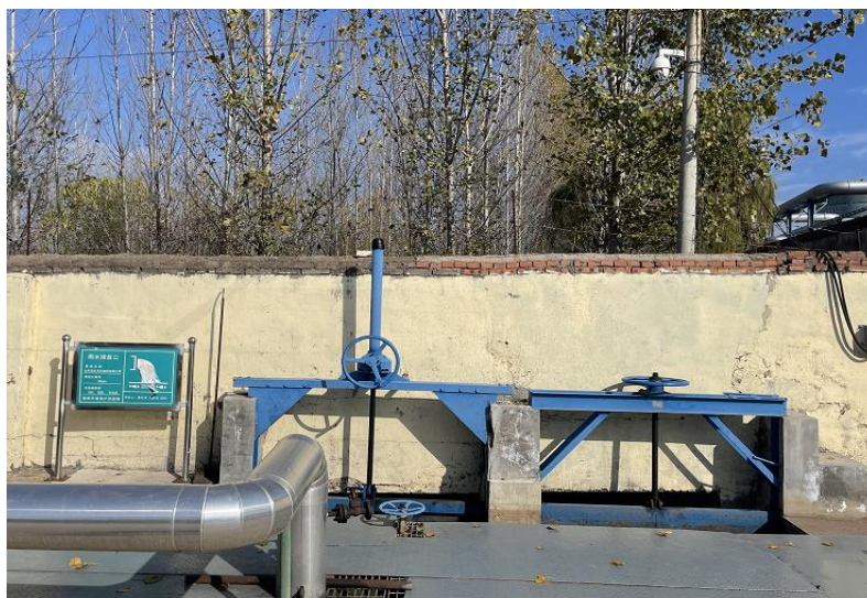
图 4-11 厂区雨水截止阀
