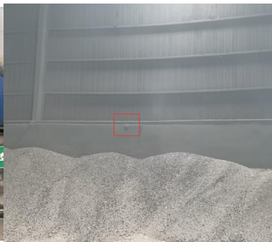
图4-6 炉渣暂存区内洒水抑尘装置
