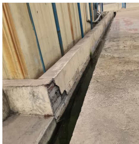
图 4-2 循环水导流槽
