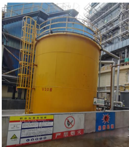
图 3-12 氨水储罐
