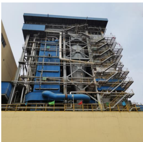
图 3-8 TG-130/3.83-M 型循环流化床锅炉 SCR 脱硝系统
