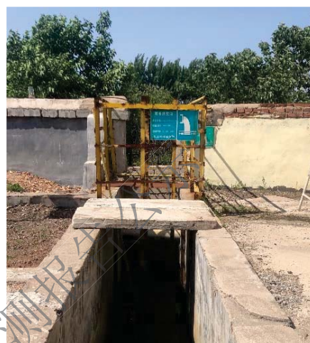
污水排放口 DW005
