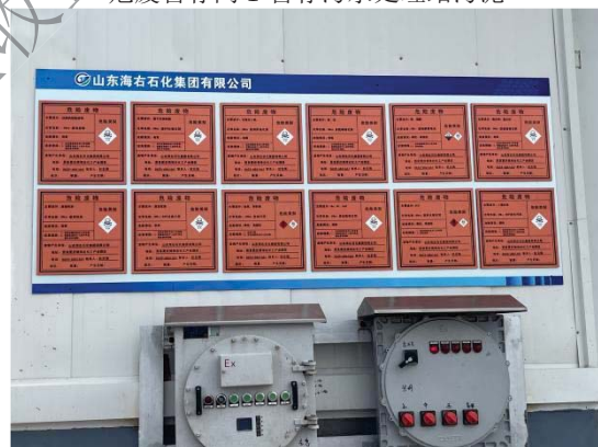
新建危废暂存间 2-外部张贴
