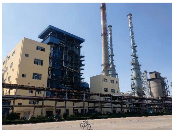
锅炉排气筒 DA013
