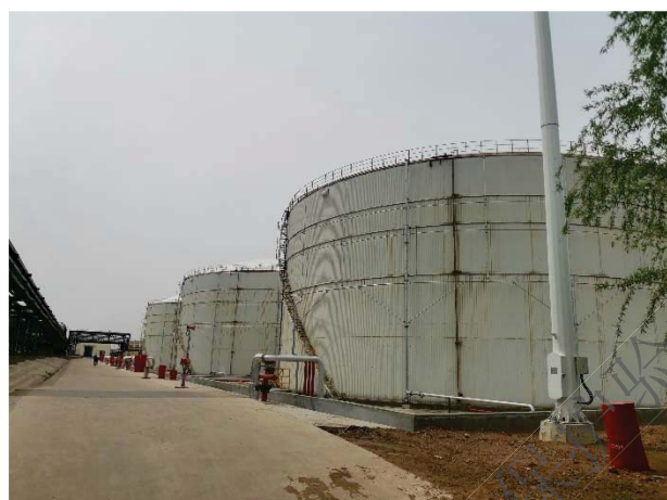
罐区周围消防设施
